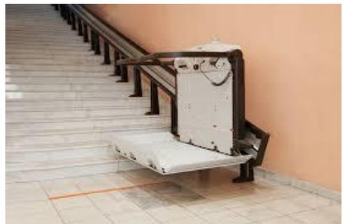
Rollstuhltypen komfortabel zwischen zwei Ebenen zu befördern. Die Konstruktion ersetzt den klassischen Schienenlauf durch eine Hebeeinheit, die am Treppengeländer oder im Treppenauge befestigt wird.
